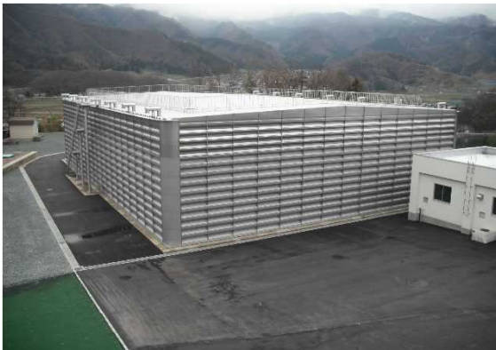
八幡山第2配水池
