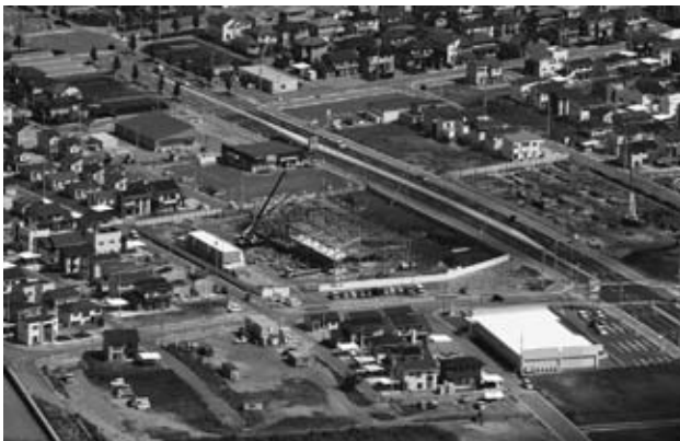
▲芳賀土地区画整理事業地内で建設中の子育て支援施設
