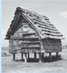
▲高床式の倉庫
