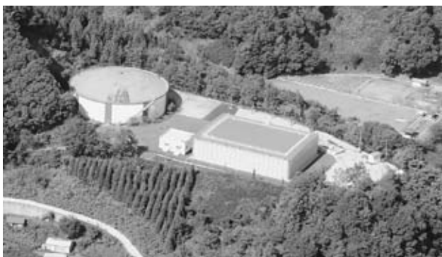
▲八幡山第2配水池（右側）
