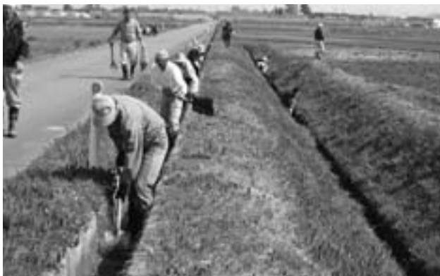
▲農業水路の泥上げ作業
